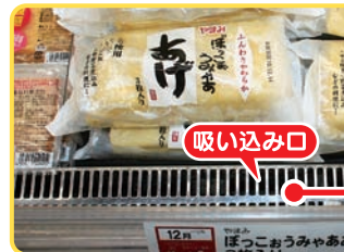
冷気は吹き出し口から吸い込み口に流れ、循環しています。吸い込み口が塞がれていると効率よく冷えず、余分なエネルギーを消費します。そこで、吸い込み口の清掃を徹底し、POPや商品で吸い込み口を塞がないようにしました。
