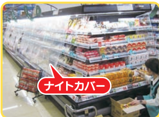
ナイトカバーは、冷蔵庫のドアと同じです。開店前の作業時には、作業するところだけ開けるようにしました。
