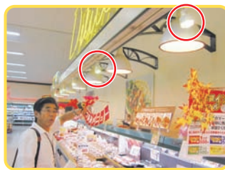
不要なスポットライトの撤去(商品の照らしすぎは、温度上昇にもつながります。(○部分を撤去))
