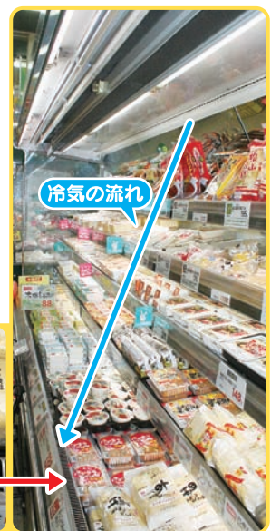
冷気は吹き出し口から吸い込み口に流れ、循環しています。吸い込み口が塞がれていると効率よく冷えず、余分なエネルギーを消費します。そこで、吸い込み口の清掃を徹底し、POPや商品で吸い込み口を塞がないようにしました。
